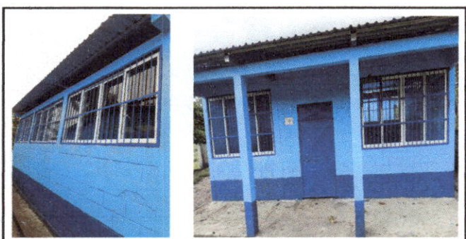
FOT 3: Sustitucion de estructura de metal de ventana por ventana de pvc.
