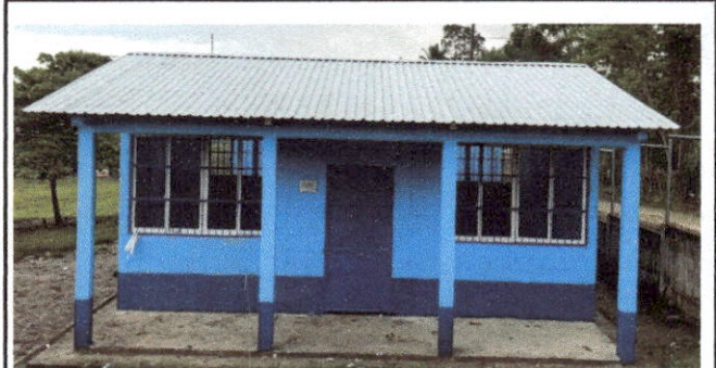
FOTO 1: Sustitucion de lamina, por lamina troquelada calibre 26
